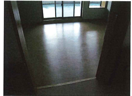
改修後 段差の無い玄関
